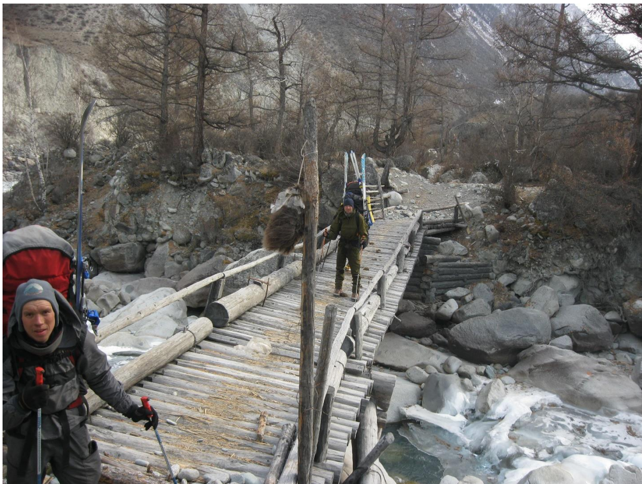
Фото 03.01-10 мост через р. Иедыгем
